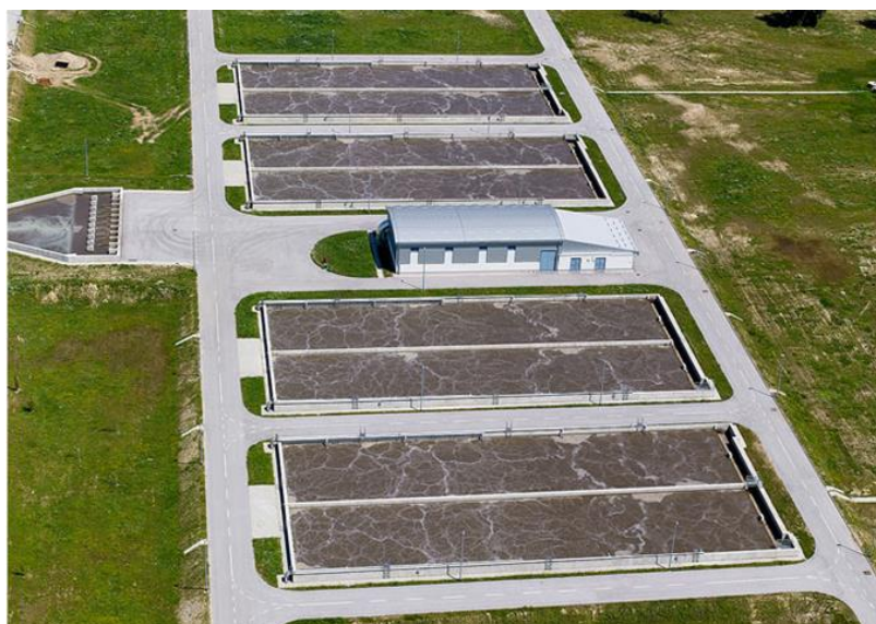
Slika 2.11. Biološki dio pročišćavanja na CUPOVZ.
