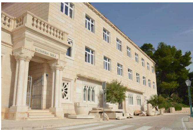
Slika 1.1. Građevina izrađena od Bračkog kamena.
