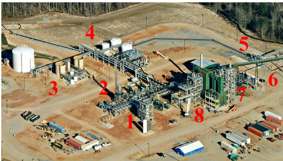
Slika 2.5. Postrojenje za biološku obradu otpadnih plinova i proizvodnju biogoriva: 1-fermentacija, 2-uklanjanje sintetičkog plina, 3-obrada otpadnih voda i skladištenje voda, 4-skladište proizvoda, 5-izvoz proizvoda, 6-rad s biomasom, 7-konverzija biomase i 8-uklanjanje čađe.
