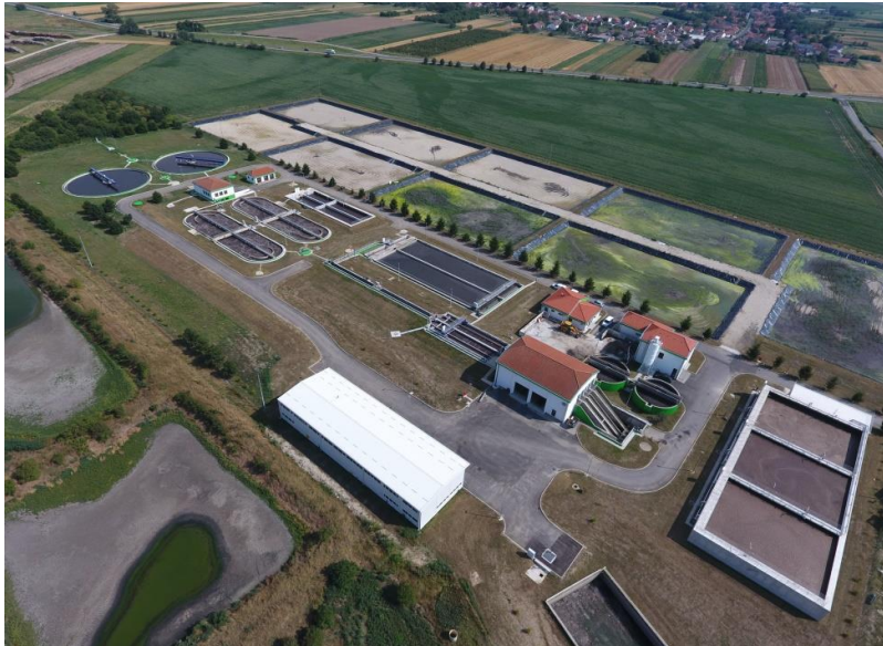
Slika 3.1. Pročistač otpadnih voda aglomeracije Čakovec
