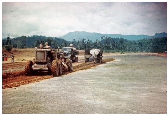
Slika 1. Postupak stabilizacije tla cementom.
