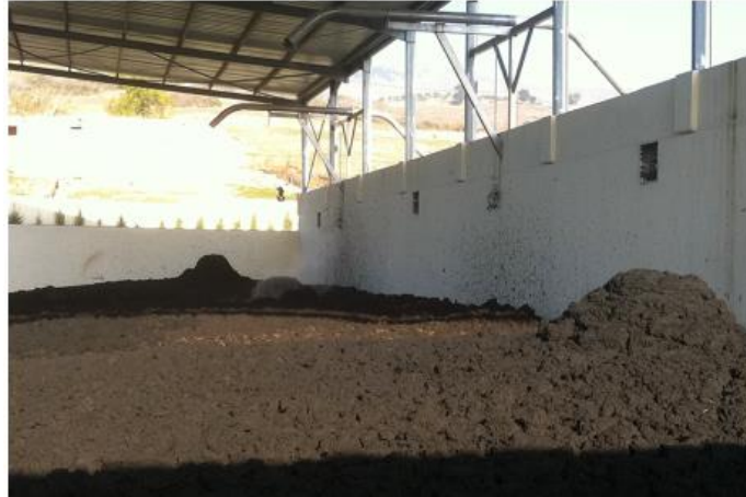
Slika 5. Jama za stabilizaciju mulja 16
