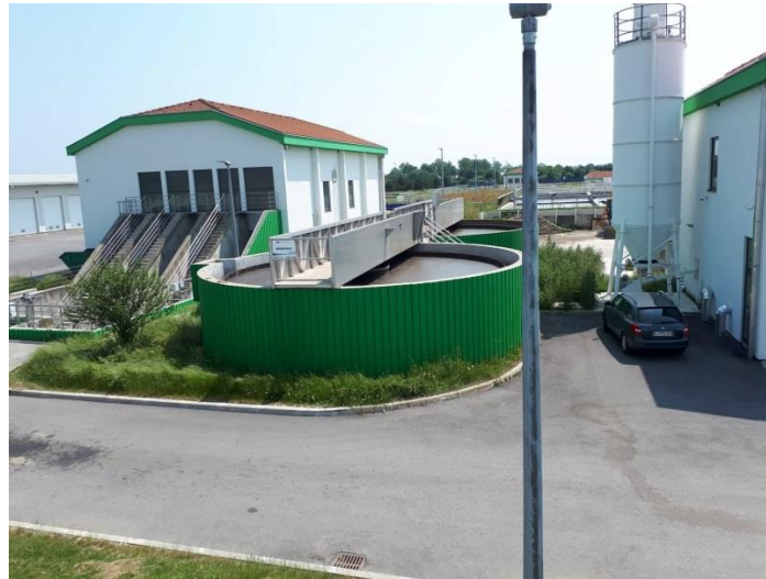
Slika 4. Zgušnjivač mulja
