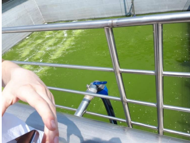
Slika 1. Flotacijski bazen
