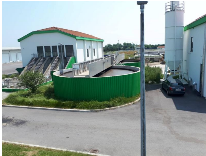
Slika 4. Zgušnjivač mulja
