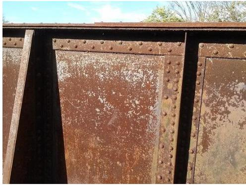
*Slika 2. Prikaz jednolike korozije na površinski velikom elementu čeličnog mosta [6].*
