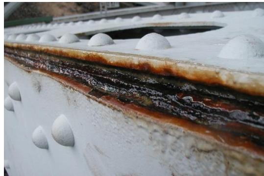
*Slika 4. Prikaz korozije u procijepu između dviju spojenih površina čeličnog mosta [8]*
