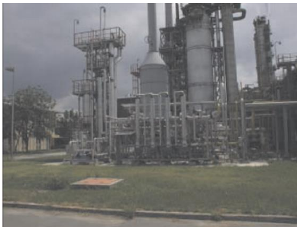
Slika 10. Postrojenje za rekuperaciju \text{NH}_3 i \text{H}_2 6
