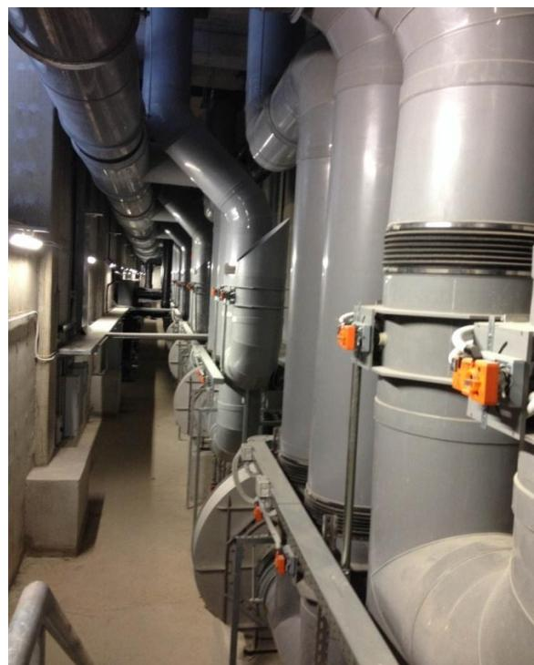
**Slika 29.** Prikaz cijevi za upuhivanje zraka za biosušenje
