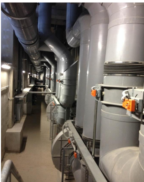
Slika 29. Prikaz cijevi za upuhivanje zraka za biosušenje
