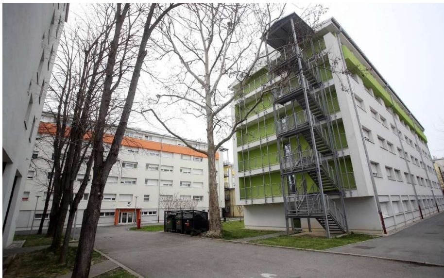
Slika 11. Primjer dobro izvedenog vanjskog stepeništa na vlastitim temeljima [19]
