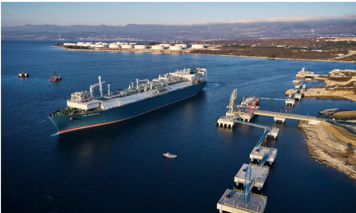
Slika 6. LNG terminal Omišalj-Krk
