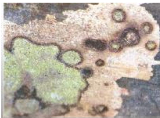
Slika 9. Izgled mikrobiološke korozije [9]
