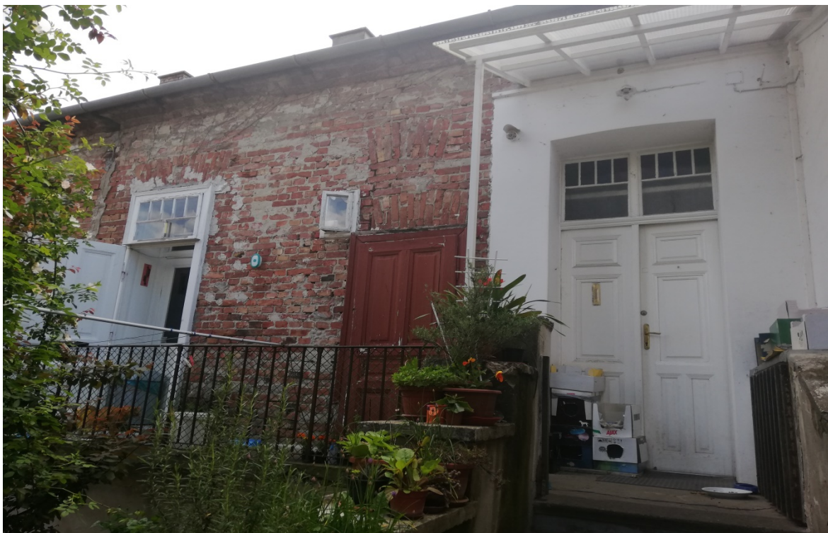
Slika 3A. Vanjska fasada sjever – dvorišna strana (zapadni dio)
