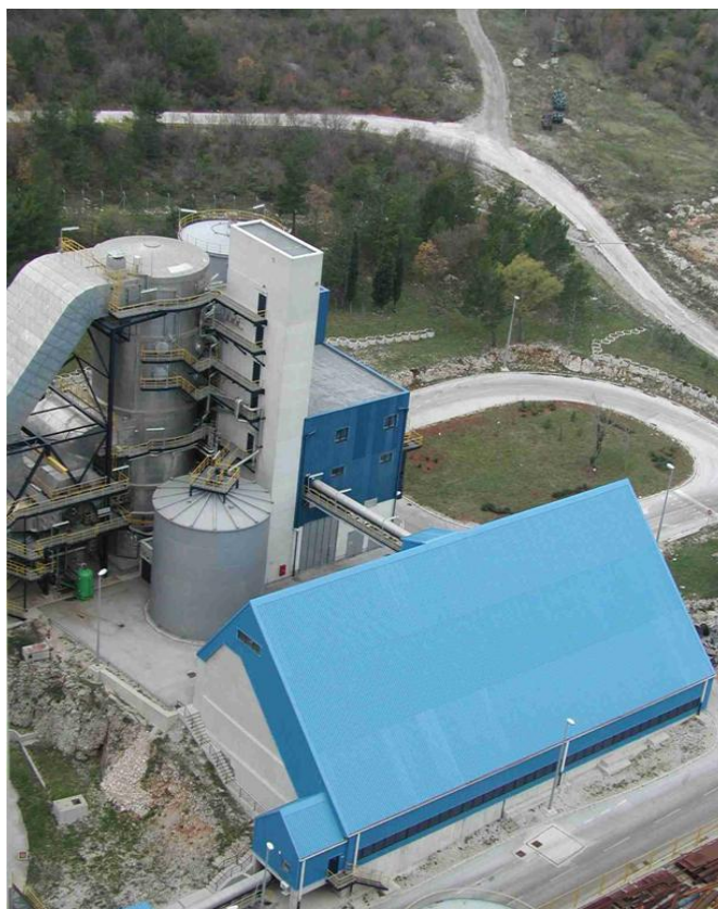
Slika 9. Postrojenje za odsumporavanje dimnih plinova [4]
