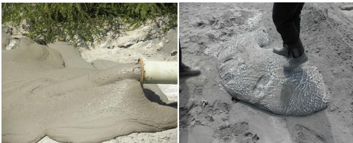
Slika 6. Mješavina pepela i vode u pastoznom stanju, na izlazu iz transportnog cjevovoda (lijevo); Kompaktna površina deponiranog pepela nakon 3 mjeseca (desno)
