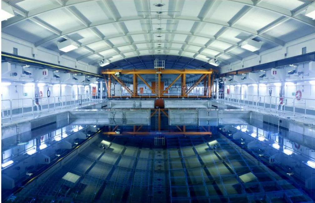
Slika 3.4. Mokro skladište istrošenog nuklearnog goriva u Švedskoj. [6]
