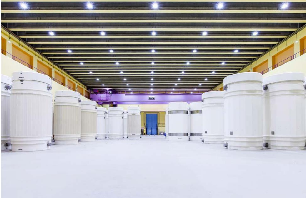
Slika 3.5. Suho skladište u Švicarskoj. [6]
