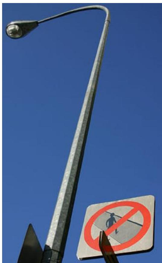
Slika 5. Stup javne rasvjete podvrgnut galvanizaciji cinkom<sup>12</sup>
