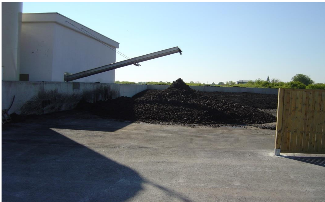
Slika 10 : Deponija dehidriranog mulja - UPOV Vinkovci
