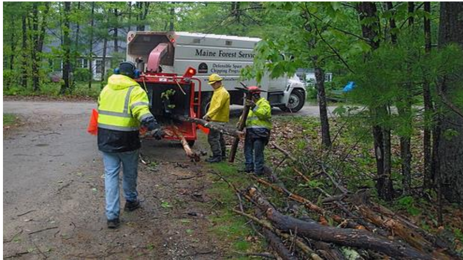
Slika 17. Prikaz iveranja i izravnog utovara na šumskoj cesti. 14
