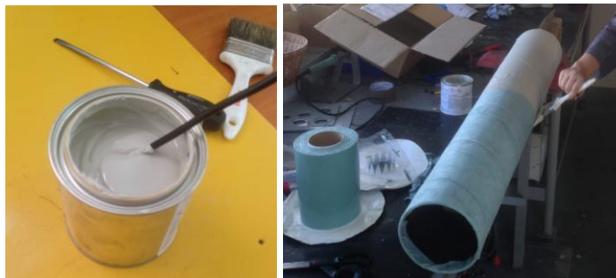
Slika 3.5. Završni premaz i apliciranje na prevlaku
