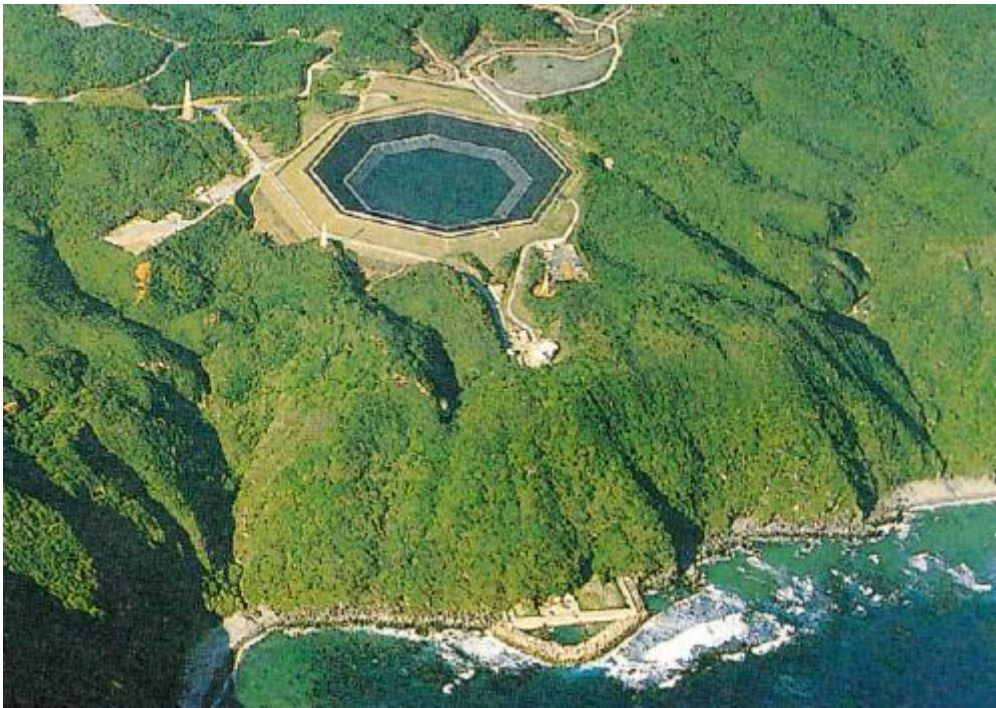
Slika 27. Prva reverzibilna hidroelektrana s morskom vodom na svijetu [30].
