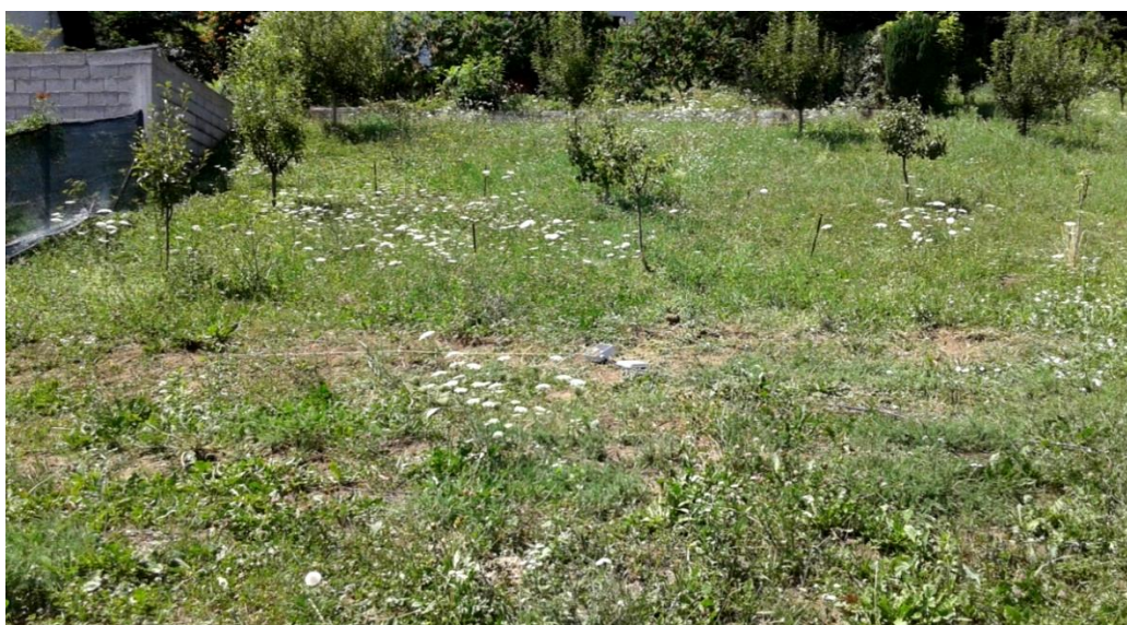
Slika 29. Teren ukopa četiri pojedinačna vertikalna anodna ležišta
