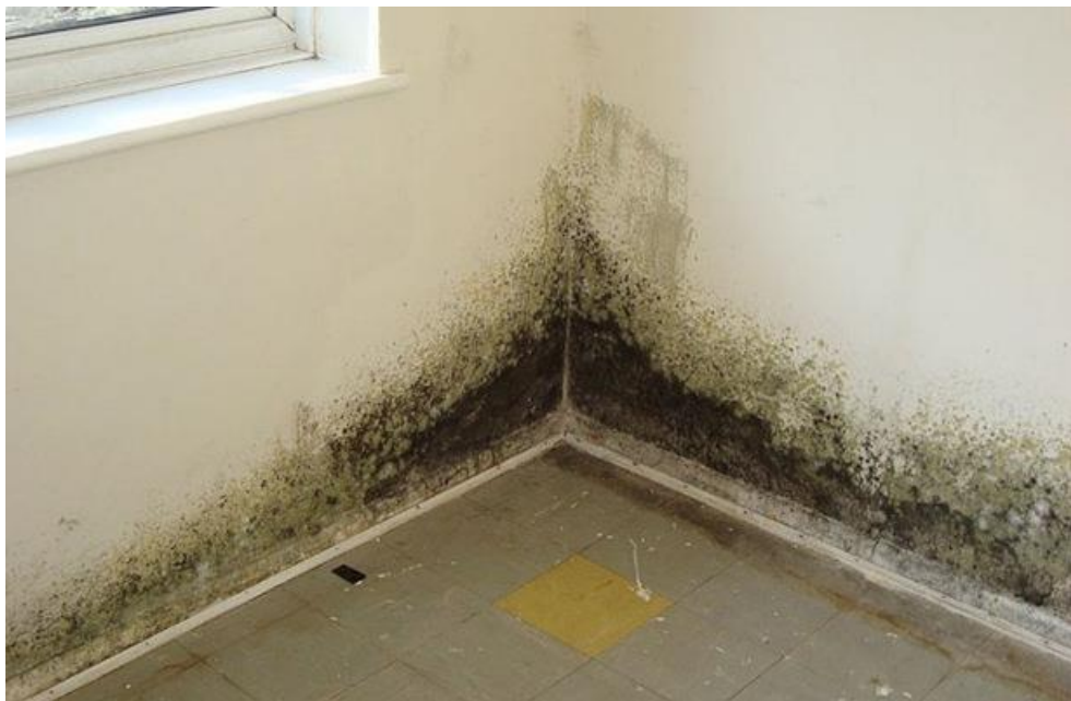
Slika 2.1.1 Primjer štetnog djelovanja vlage
