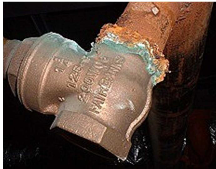
**Slika 2.6.** Primjer galvanske korozije na mjestu kontakta mjedi i čelika
