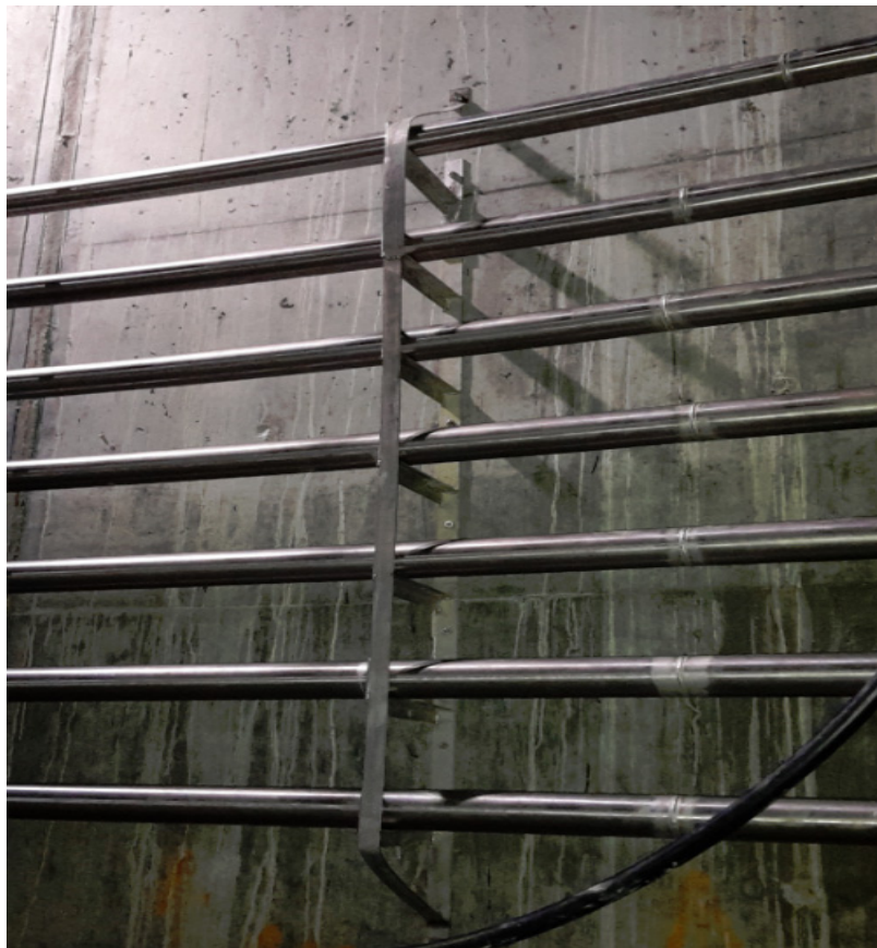
Slika 14 Grijaće cijevi u reaktoru [41]
