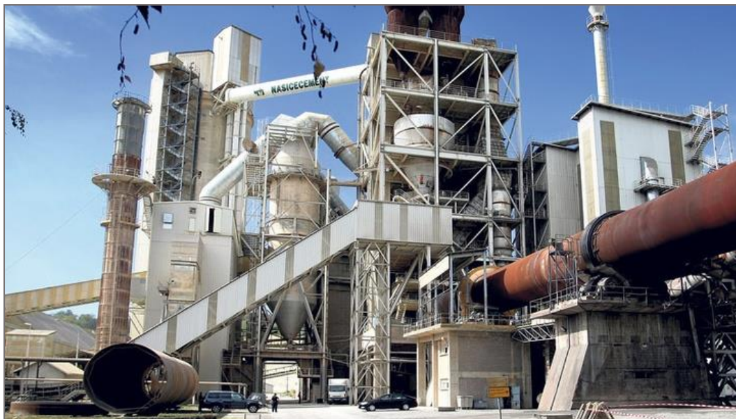
Slika 3. Prikaz postrojenja za suhi postupak proizvodnje cementa u Našicecementu d.d. Našice
