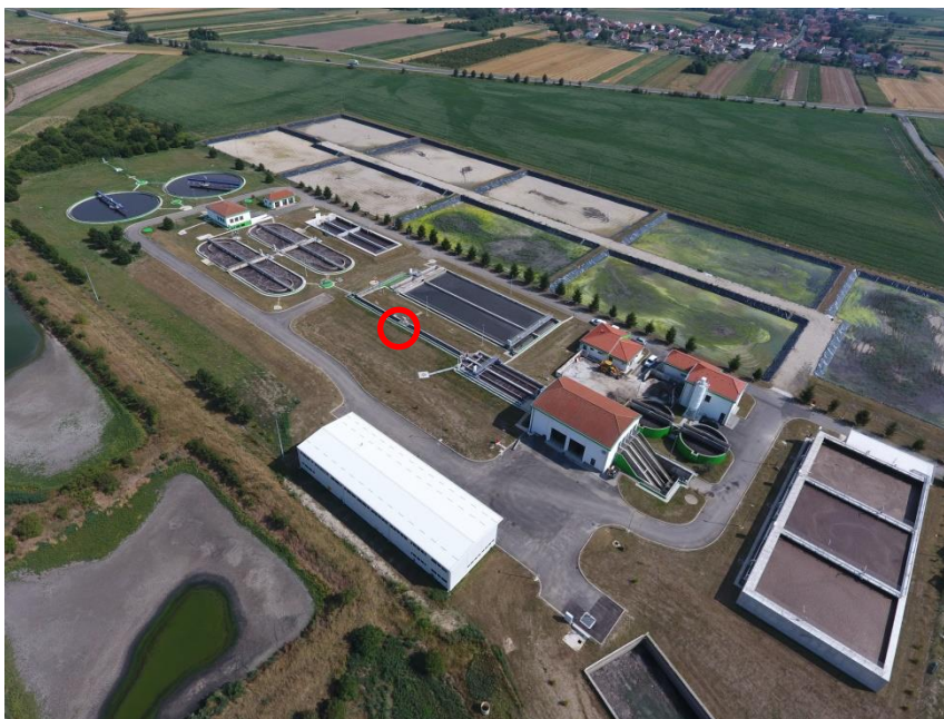
Slika 7. Pročištač otpadnih voda aglomeracije Čakovec
