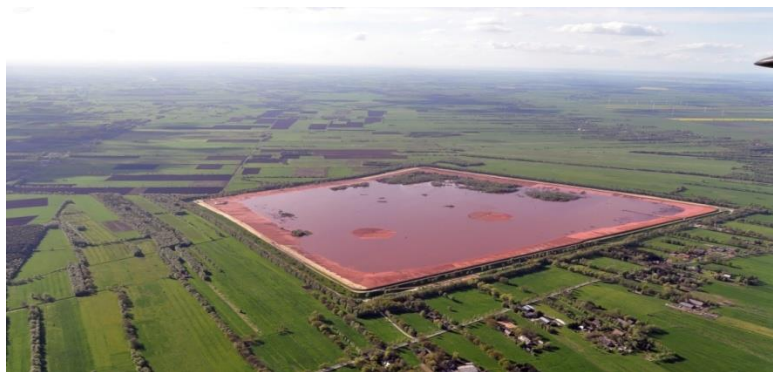
Slika 11. Bazen za odlaganje crvenog mulja u Njemačkoj [78]
