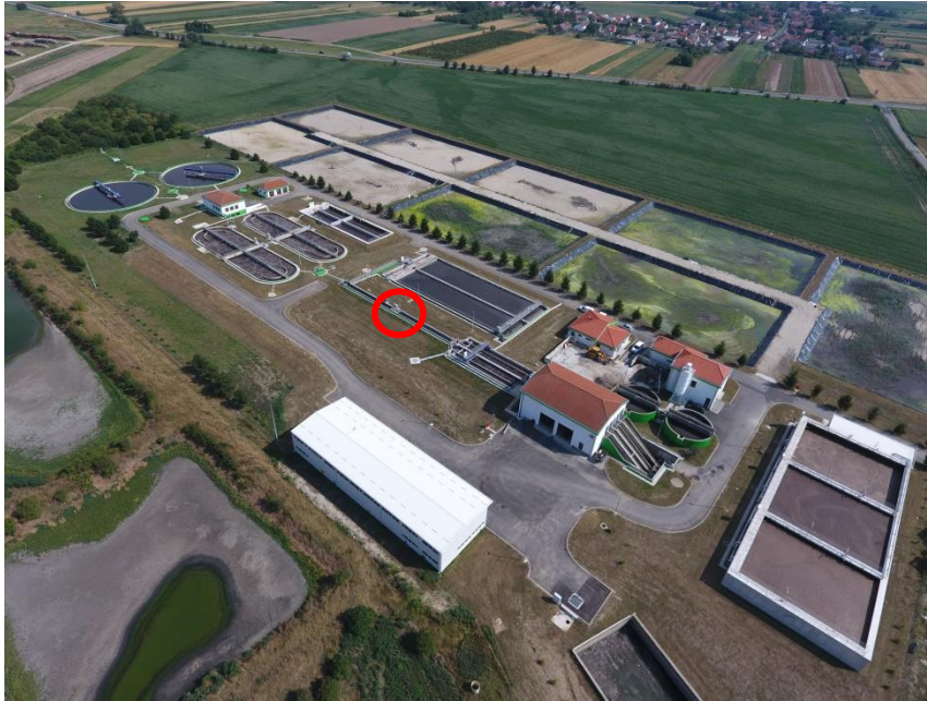
Slika 3.1. Pročistač otpadnih voda aglomeracije Čakovec
