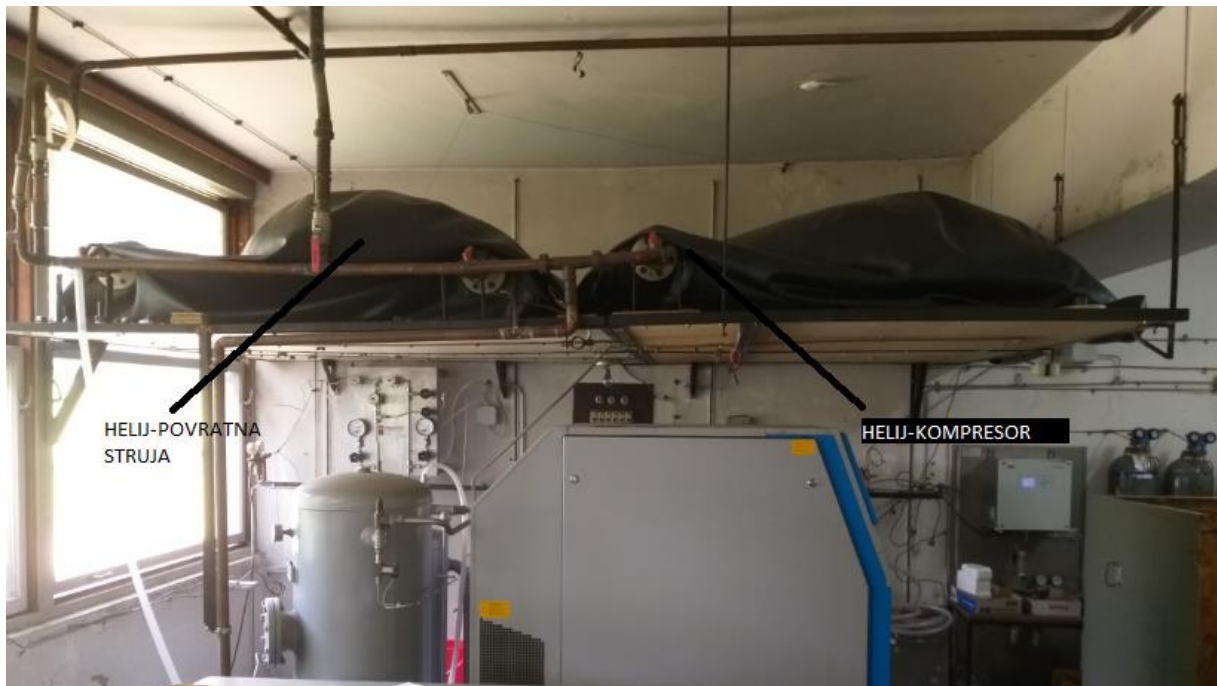
Slika 22. Održavanje minimalnog tlaka odvođenjem helija u povratnu struju ( lijevo ) i spremište helija koji ulazi u kompresore ( desno )
