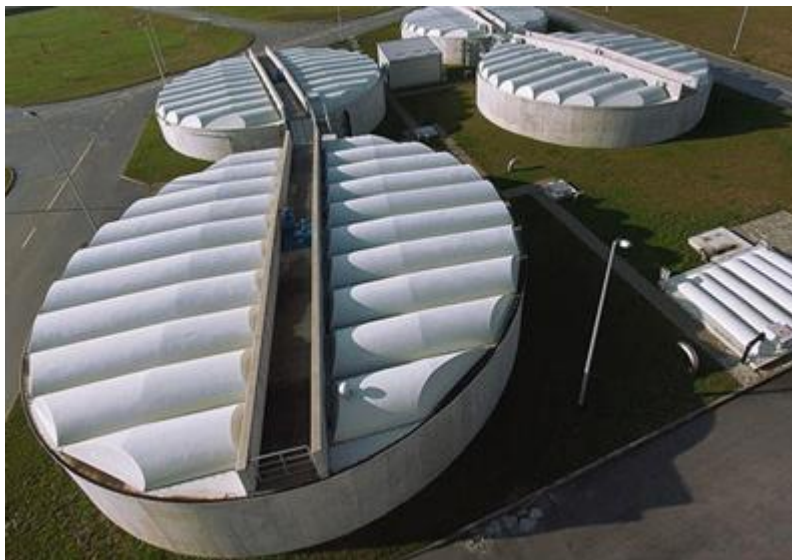
Slika 2.13. Prethodni i naknadni gravitacijski zgušnjivači na CUPOVZ.
