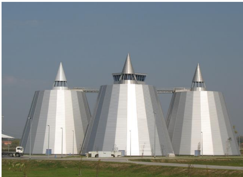
Slika 2.15. Digestori na CUPOVZ.
