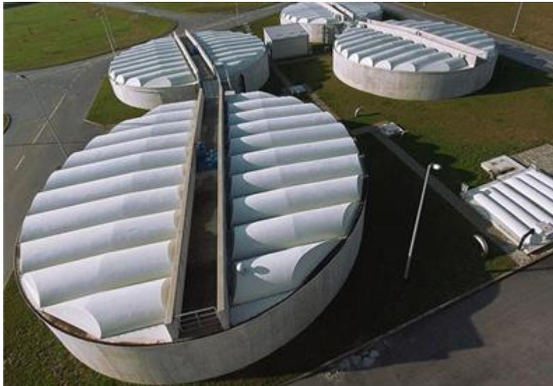
Slika 2.13. Prethodni i naknadni gravitacijski zgušnjivači na CUPOVZ.
