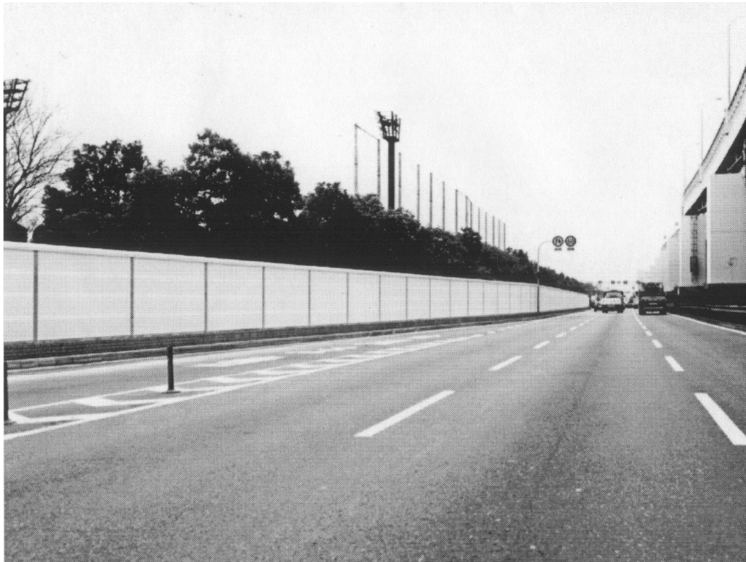
Slika 15. Zvukobran u Japanu prekriven slojem \text{TiO}_2 fotokatalizatora u svrhu otklanjanja \text{NO}_x spojeva [36].
