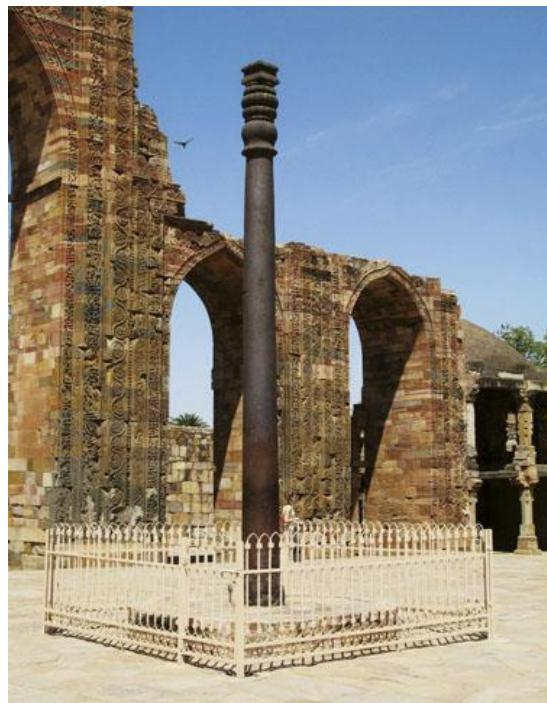
**Slika 2.** Prikaz nekorodirajućeg željeznog stupa u Delhiju<sup>5</sup>
