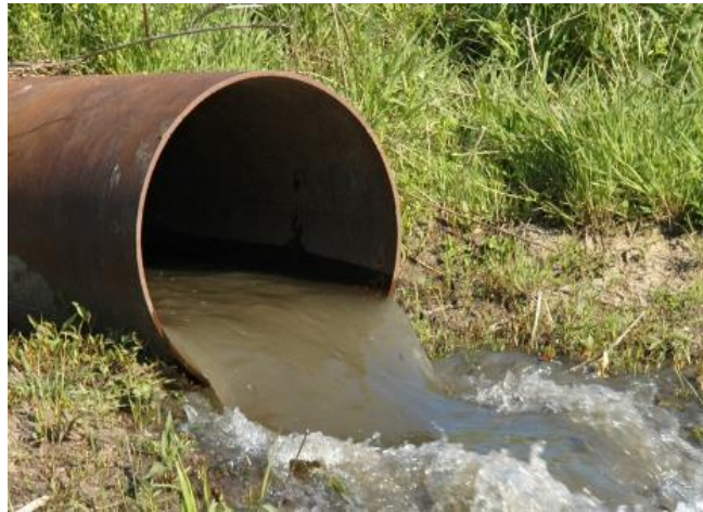
Slika 2.1. Komunalna otpadna voda
