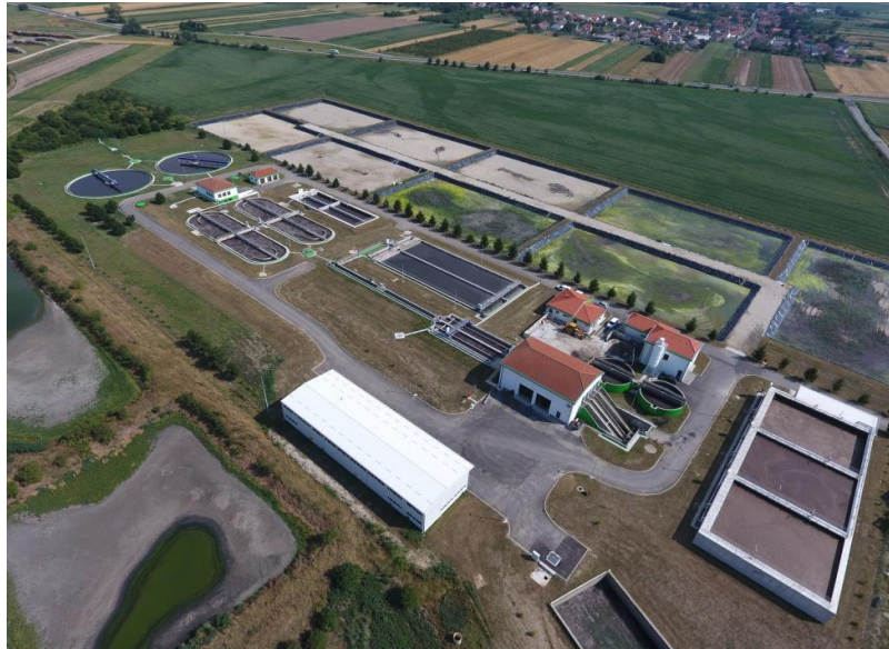
Slika 3.1 . Pročistač otpadnih voda aglomeracije Čakovec
