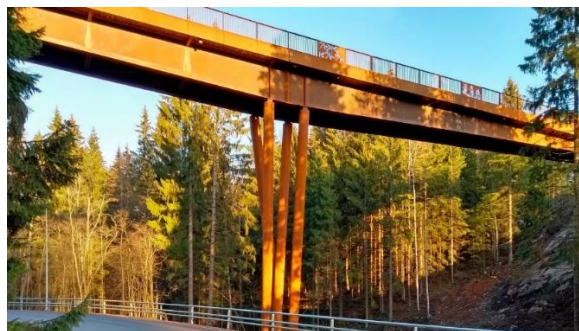
Slika 12. Prikaz mosta izgrađenog od čelika otpornog na vremenske uvjete [24]
