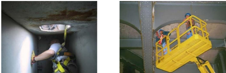
Slika 13. Teškoće kod izvođenja vizualnog pregleda čeličnog mosta: a) slabo osvjetljenje, b) rad na visini [28]
