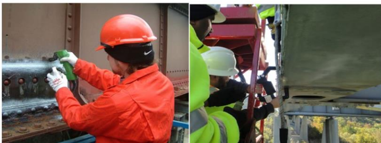
Slika 16. Prikaz inspekcije čeličnih mostova primjenom metode s magnetskim česticama [28]
