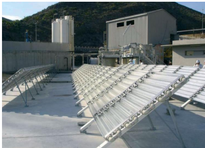
Slika 5. Solarna foto-Fenton jedinica. [8]
