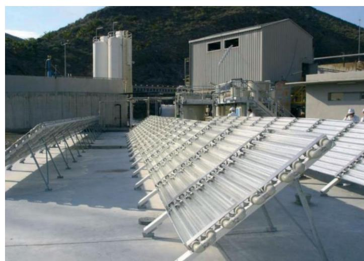
Slika 5. Solarna foto-Fenton jedinica. [8]
