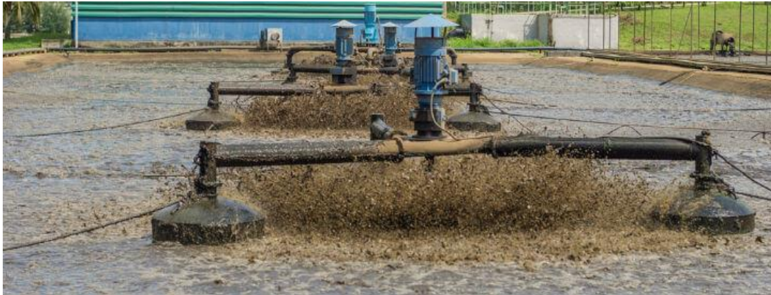
Slika 1. Obrada otpadne vode aktivnim muljem [4].
