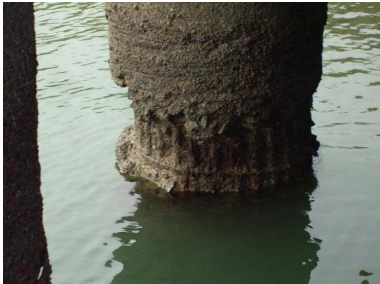
**Slika 4.** Primjer elektrokemijske korozije, uz vodenu liniju stupa [11]
