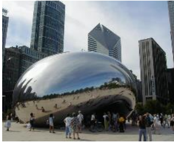
Slika 12. Građevinski objekt napravljen od nehrđajućeg čelika 6
