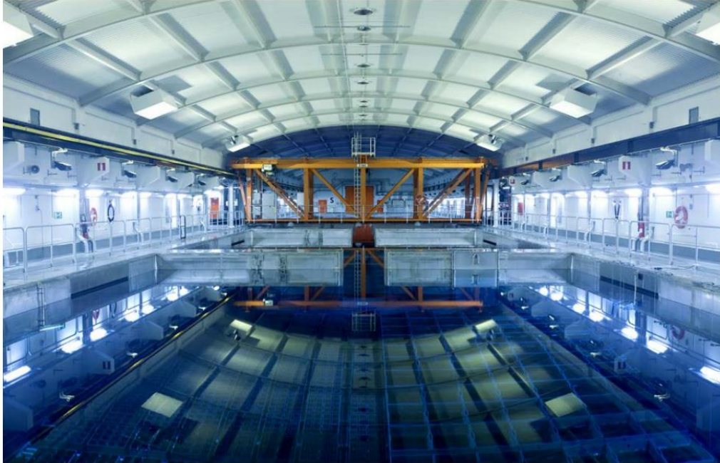
Slika 3.4. Mokro skladište istrošenog nuklearnog goriva u Švedskoj. [6]
