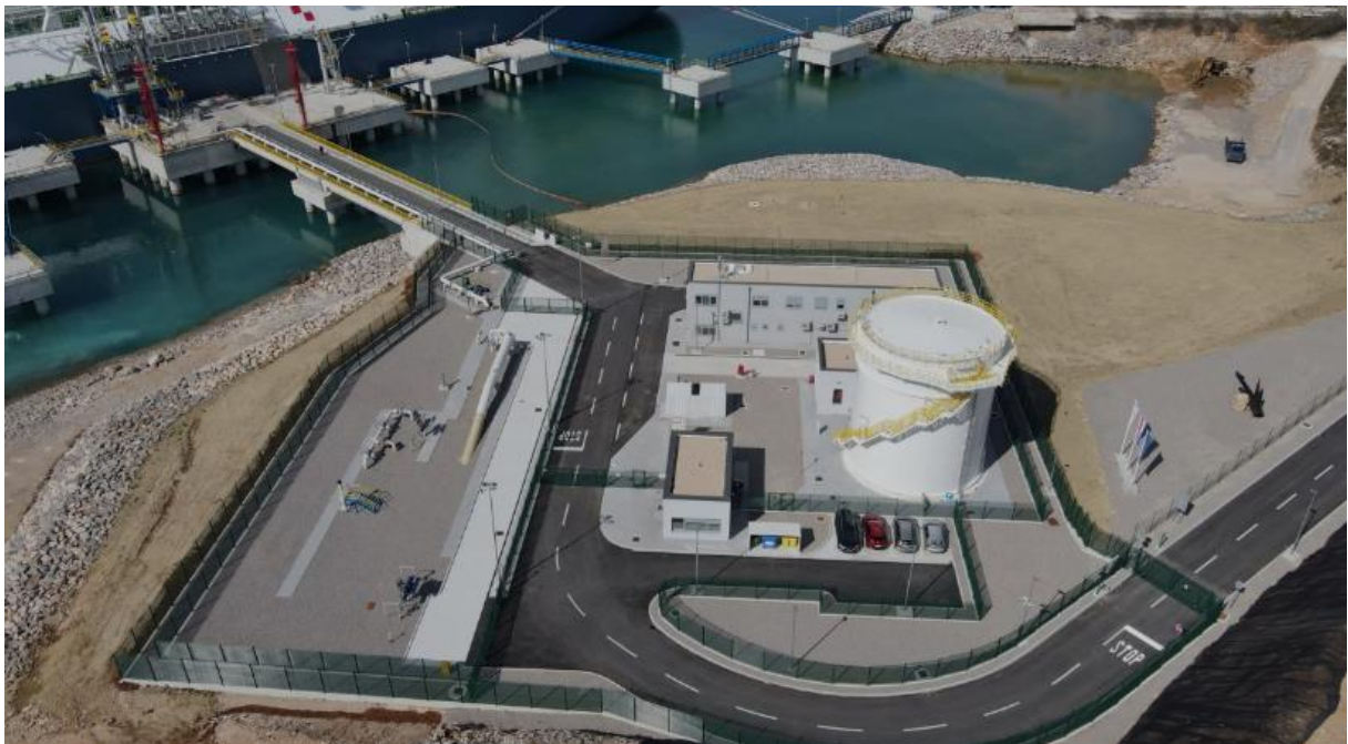
Slika 3. Kopneni dio LNG terminala [6]
