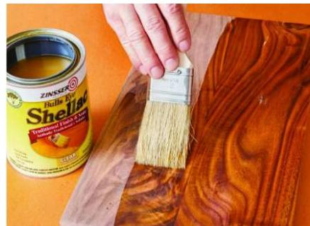
Slika 5. Primjena šelaka kao premaza za drvene površine (7)
