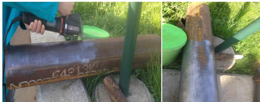
Slika 3.2. Predobrada površine rotacijskom četkom
