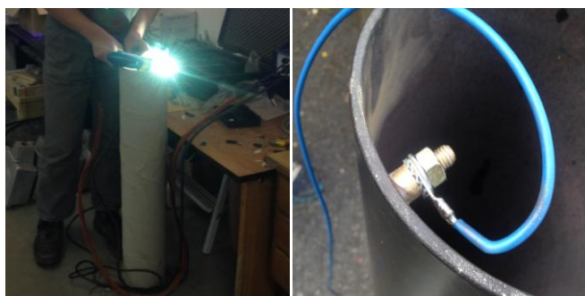
Slika 3.6. Zavarivanje kablova na uzorke
