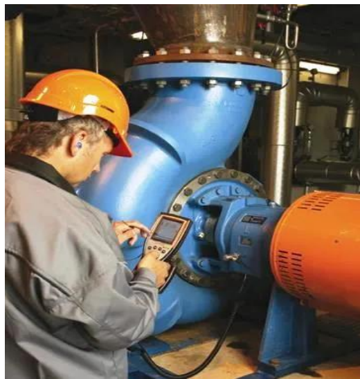
Slika 4. Otkrivanje kvara u ležaju
