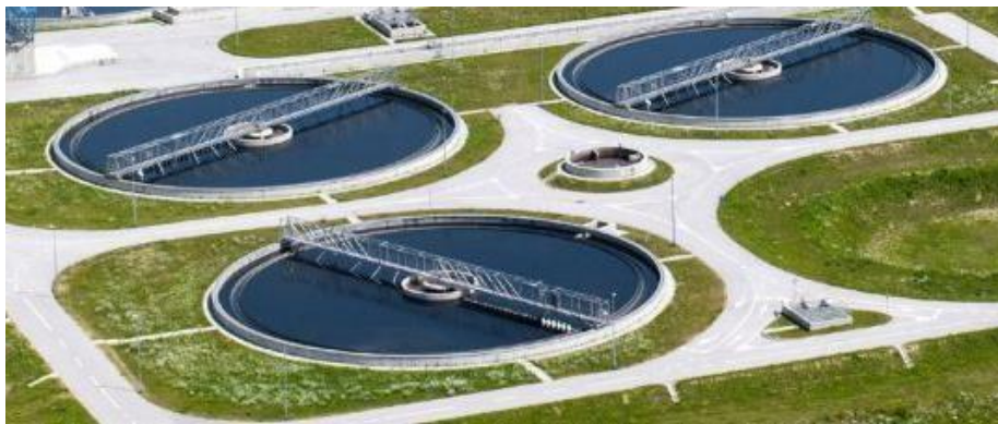
Slika 3. Kružni taložnici na Zagrebačkim otpadnim vodama [10]
