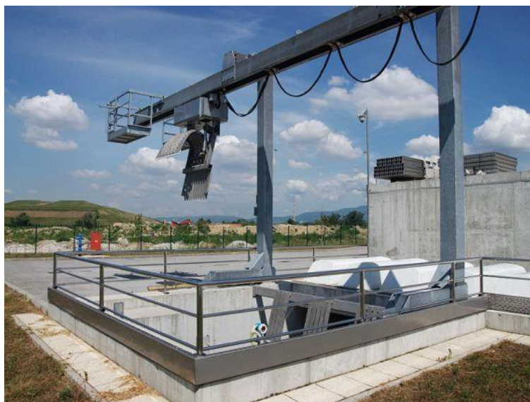
Slika 1. Pokretna rešetka na uređaju za mehaničku predobradu Zagrebačkih otpadnih voda [12]
