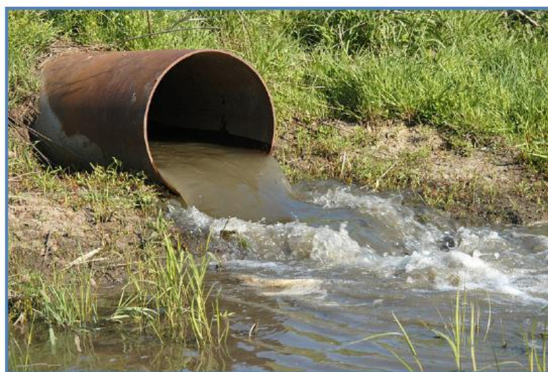
Slika 3. Nekontrolirano ispuštanje nepročišćenih otpadnih voda u okoliš 5
