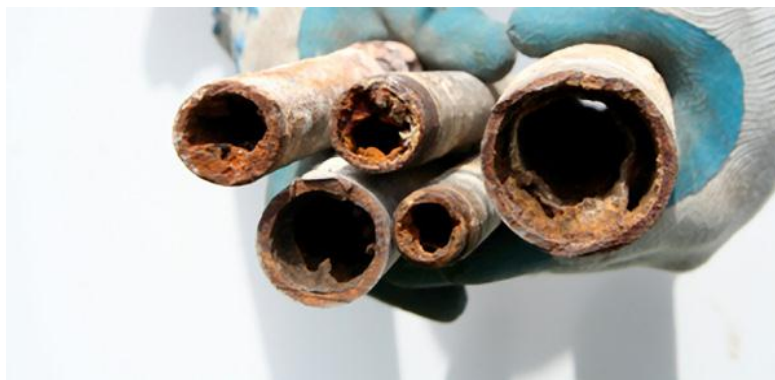
Slika 2. Stare olovne cijevi za dovod vode za piće u domaćinstva
