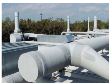
Slika 8. Metakrilatni silani koriste se kako bi se staklo-plastika vezala za poliester na krovovima otpornim na koroziju 6
