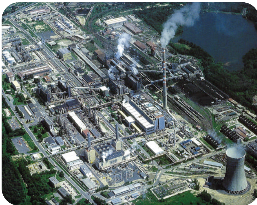
Slika 25. IGCC postrojenje u Vresovi, Češkoj 12
