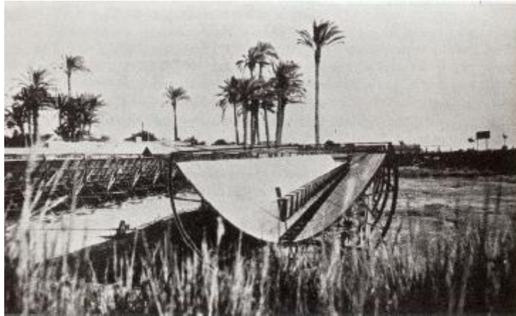
Slika 4. Shumanovo postrojenje solarnih paraboličnih kolektora u Meadi, Egipat [8].
