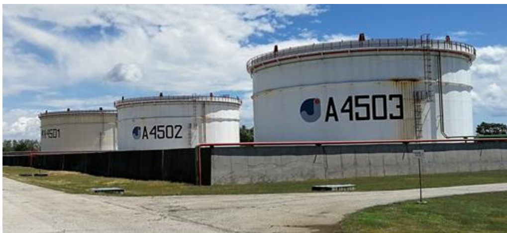
Slika 2.5. Spremnici za skladištenje nafta u Janaf-ovom terminalu Virje.
