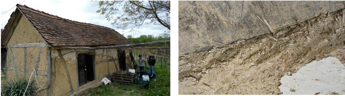
Slika 2.4.1. Primjer kompozitnog materijala blato (glinenica, voda) i biljna vlakna v
